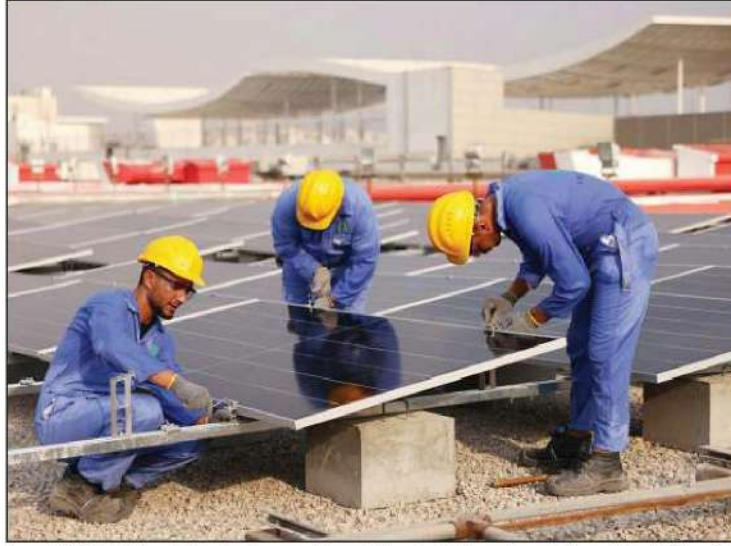
تركيب الألواح الشمسية ضمن توجه المباني نحو التوسع التدريجي في استخدام حلول الطاقة المتجددة
